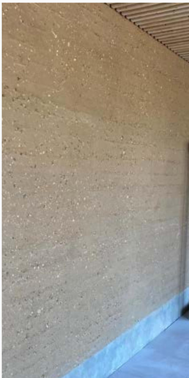
Mur en pisé du Siège de la CCPA à Sain-Bel
